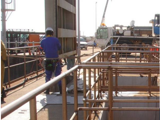
角落としの設置
