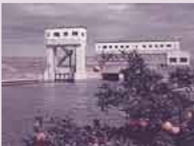
勢濃排水樋門
