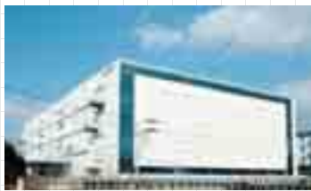
本宮事業所 新棟(建設中) Motomiya office New building (under construction)
