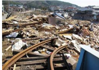
E【線路流失】 ほそら (大船渡線 細浦構内)
