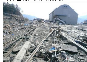
I【線路流失】 おながわ (石巻線 女川構内)
