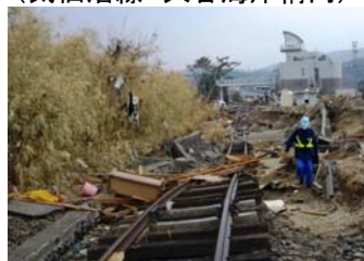
G【線路流失】 おやかいかん (気仙沼線 大谷海岸構内)
