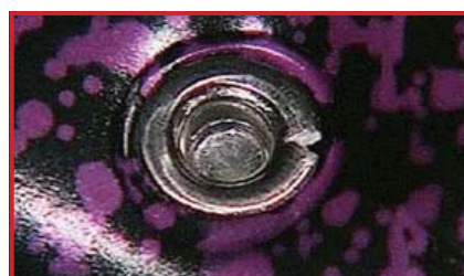
リベットの損傷 (廃棄)
