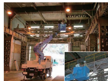
旧横須賀海軍工廠建物の実測調査 Survey of old Yokosuka naval arsenal
