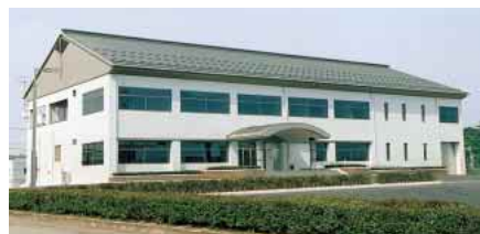
新コンピュータセンター全景
