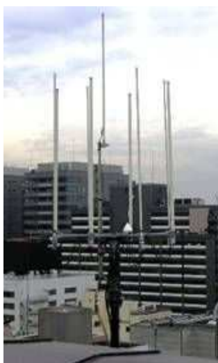
実際の基地局施工状況
