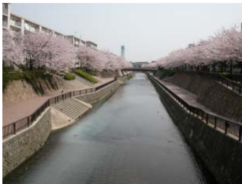
写真 4 - 1 1 都営南田中団地付近 (施工例)
