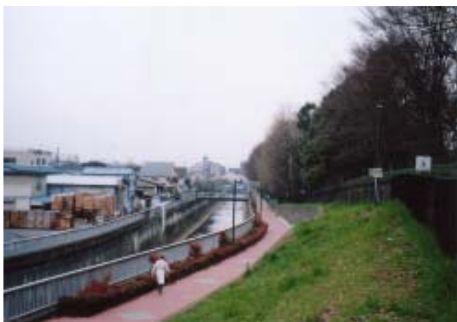
写真 4 - 7 城北中央公園付近現況写真
