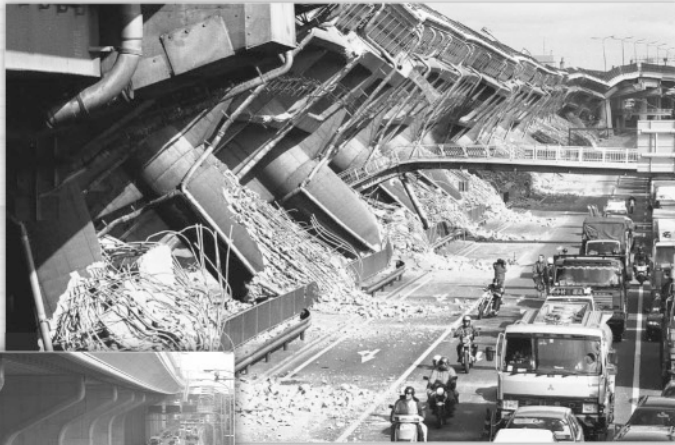
神戸市灘区深江本町で約600mにわたって壊壊しになった阪神高速道路神戸線。1年8か月後の1996年9月に全線開通した
