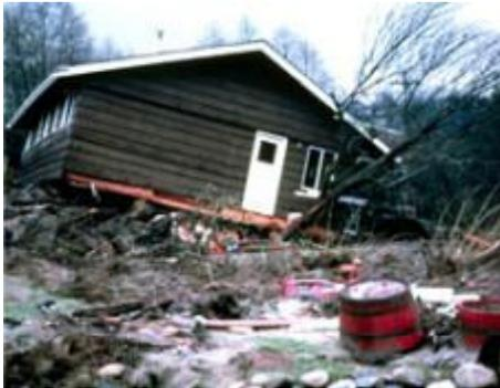
ツーバイフォー工法の特徴は、構造耐力に優れた枠材と面材とが一体となった『面』で支える構造であり、6面相互の緊結により家を形づくりします。これにより地震や台風などの力を建物全体で受け止め、荷重を一点に集中させることなく全体に分散してしまうので、外力に対して抜群の強さを発揮します。さらに面構造によって高い断熱性や気密性も確保され、快適で高性能な住まいが実現されています
