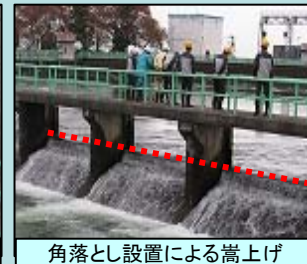
角落し設置による嵩上げ
