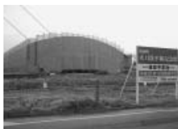
大刀洗平和記念館建築工事風景
