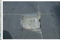
4 通り井の跡 江戸時代の水道井戸の跡。道の真ん中に「井」と書かれた石が埋め込まれている。
