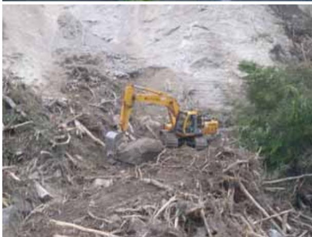
遠隔操縦式油圧ショベル
