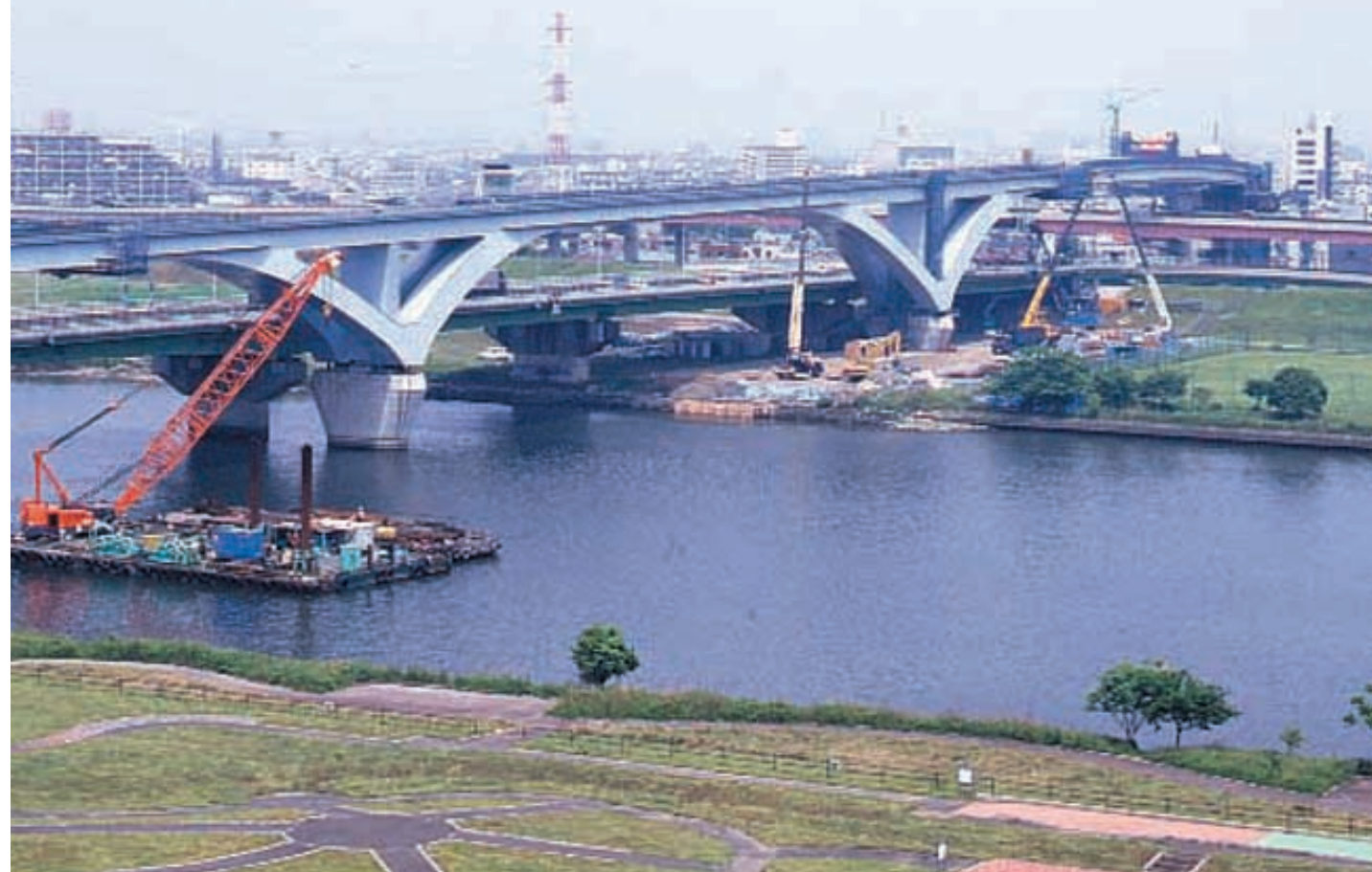
小台一丁目側から見た荒川横断橋りょう（仮称）
