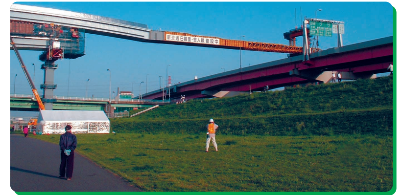
4月18日朝、首都高上空架設中の写真です。
