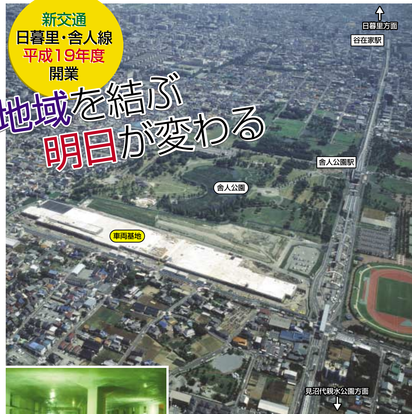
工事が進む車両基地と舎人公園駅周辺（平成17年8月撮影）
