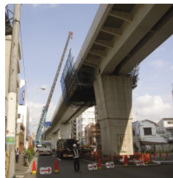
クレーン車による荷上げ作業と交通規制
