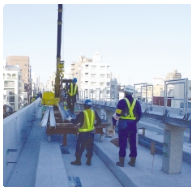
走行路上の案内軌条工事
