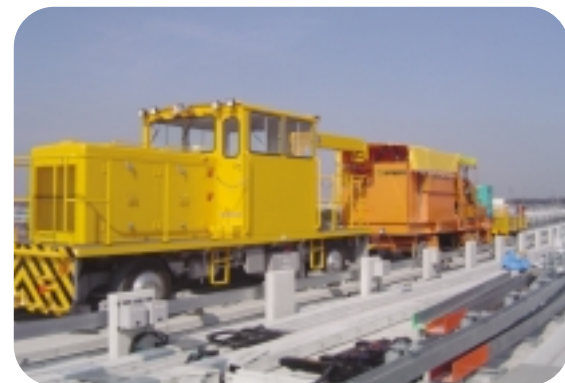
作業車を使った走行路整正作業 (舎人公園駅付近)
