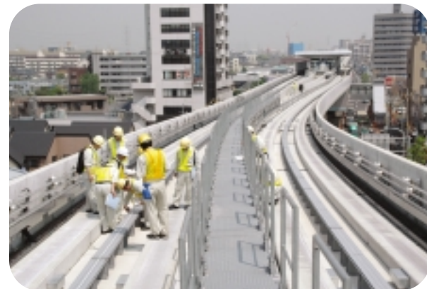
信号通信システムの調整作業 (扇大橋駅付近)
