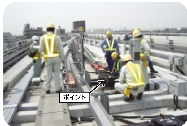
列車の進路を振り分ける「ポイント」の調整作業 (見沼代親水公園駅付近)
