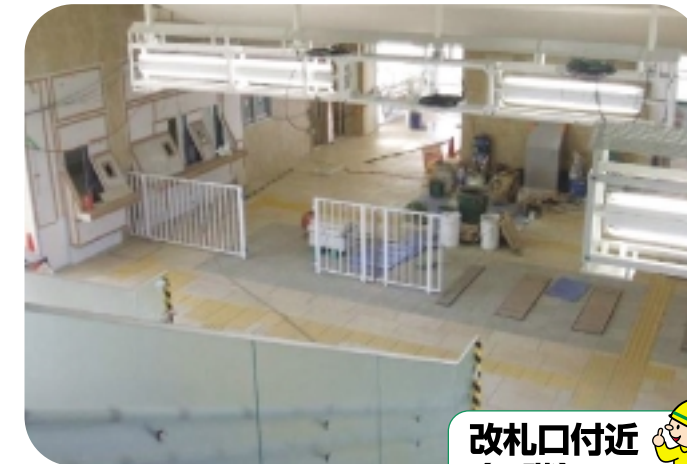
ホーム階(3階) タイル貼り作業
