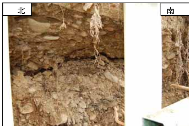
写真 4.4.2 掘削調査時に公園側鉛直断面で観察された地盤クラック
