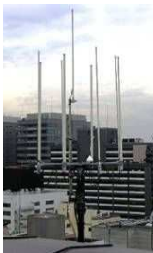
実際の基地局施工状況
