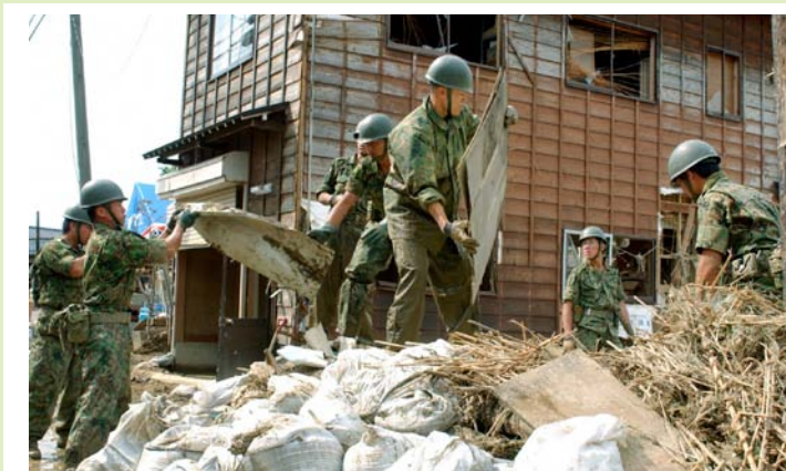
集中豪雨による被災地で復旧作業を進める陸上自衛隊員 (PANA通信社提供)
